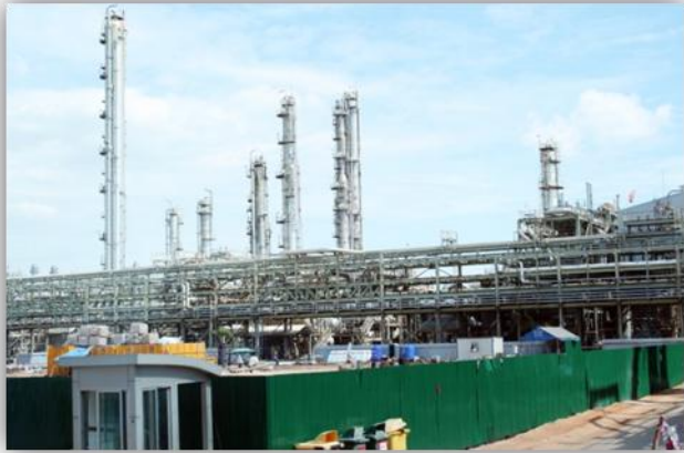
พื้นที่ก่อสร้างโครงการหน่วยผลิตโพรพิลีน
